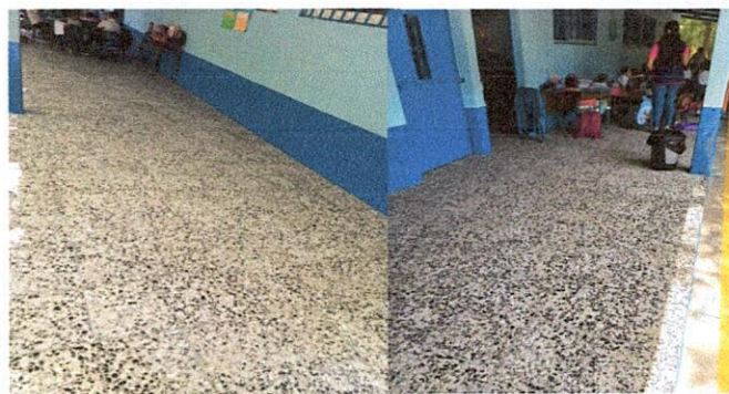
Foto 2: Sustitución de piso de concreto con acabado liso por piso de granito, incluyendo preparación de superficie y nivelación.
