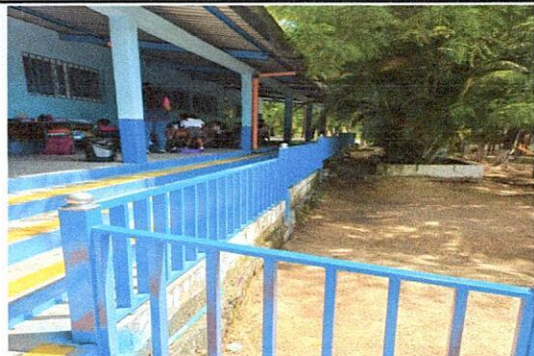
Foto 1: Sustitución de barandales metálicos, incluyendo fijaciones, pintura y soldaduras.
